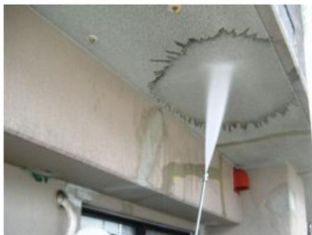
・高圧水洗浄（水圧：10～15MPa）
