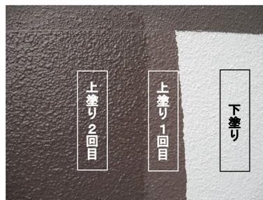
内外壁塗装部は、下塗材にて一度真っ白に塗装します。その後、上塗材にて仕上げ色に塗装いたします。
