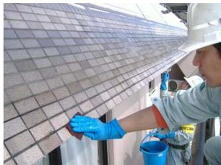
塗装面は塗膜の接着を良くする為、ホコリ・苔・油分等を高圧水洗浄にて洗い流します。
