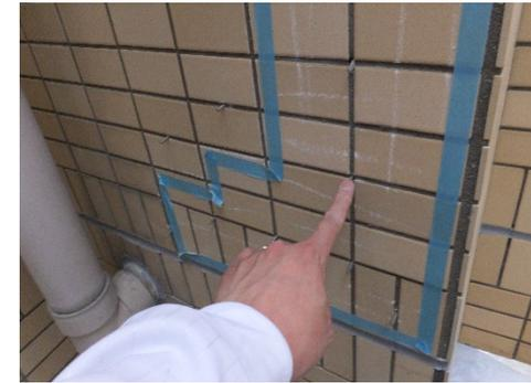
・剥落防止、タイル浮き部拡大防止の為のステンセスピン挿入
