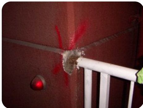
・劣化部コンクリートを撤去
