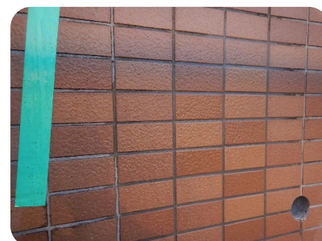
・タイル張り完了
