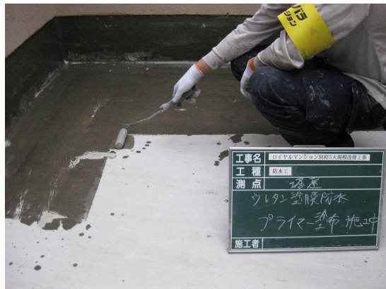
・ケレン・清掃後、プライマー塗布
