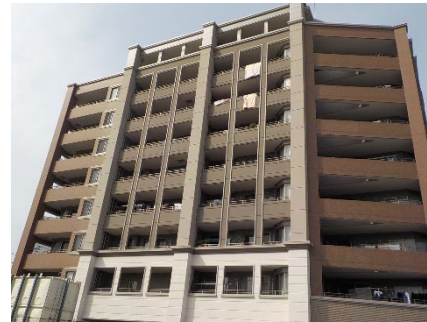
アーサー新宮 コンドミニオ EAST 28戸 平成31年2月完工
