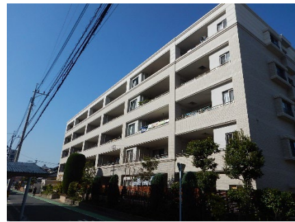
アーサー室見 サウスステージ 28戸 令和元年6月完工
