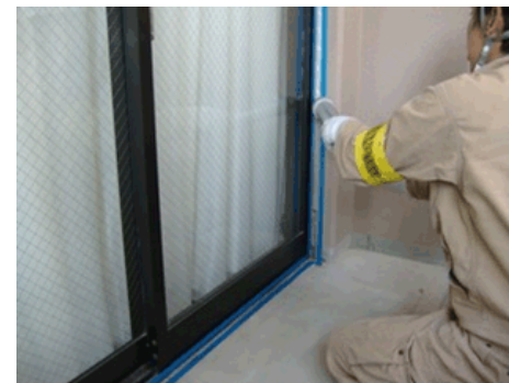
・新規シーリング材を打設
