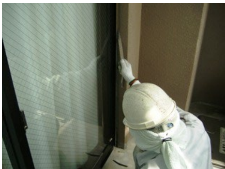
・既設シーリング材を撤去
