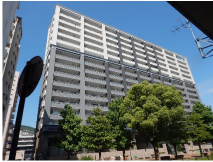
アルフィーネ 佐世保駅前 124戸 令和元年6月完工
