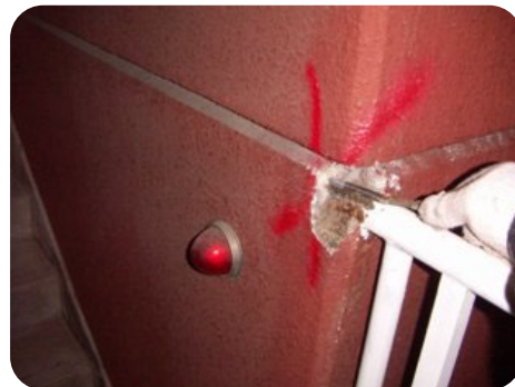
・ワイヤーブラシを使い錆を落とし防錆処理
