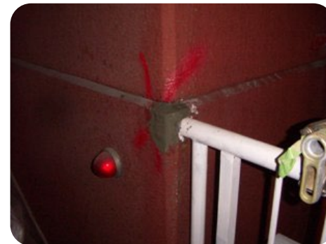
・樹脂モルタル埋め戻し
