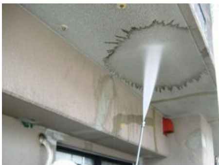
・高圧水洗浄（水圧：10～15MPa）
