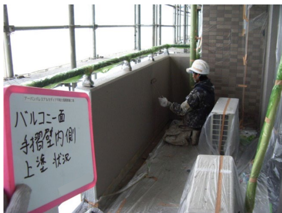
内外壁塗装（バルコニー手摺壁）
