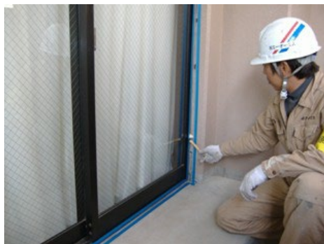
・清掃後プライマー塗布
