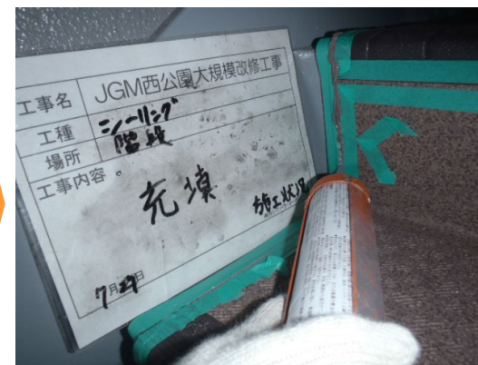
・端末シール打設
