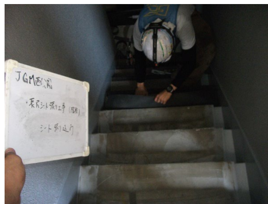
・長尺シート敷設
