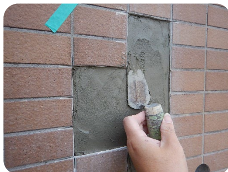
・劣化部タイルを撤去を行い、ひび割れ補修完了後、貼り付けモルタル塗り付け
