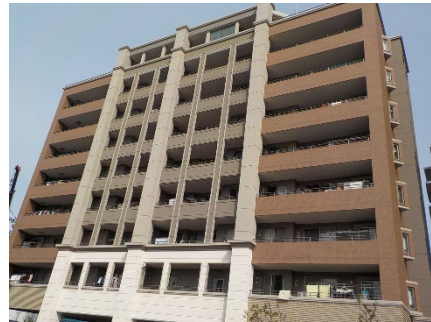
アーサー新宮 コンドミニオ WEST 28戸 平成31年2月完工
